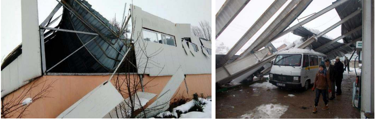
Şekil 2. Yenişehir’de düğün salonunun ve akaryakıt istasyonunun kar yağışı sonrası göçtükten sonraki görünümü [2]
